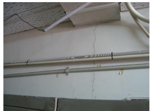
壁面の亀裂
