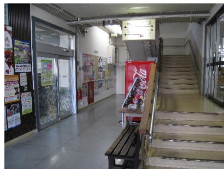
エレベーター設置が困難なロビー
