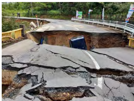
図 1-3 川西ダリヤ園に向かう町道及び鏡沼(大光院堤1号)の被災状況
