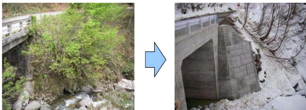
図-10 ボックスカルバートへの更新イメージ図(山形県橋梁補修ガイドライン 抜粋)
