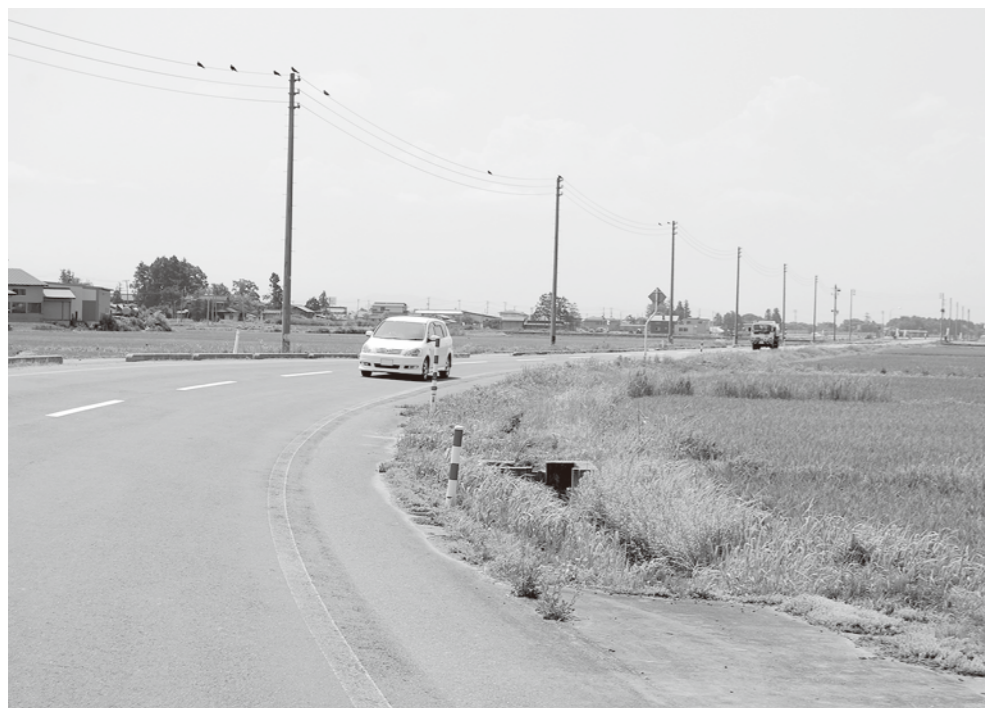
町道大塚東線 防雪柵設置は町道では初めて
