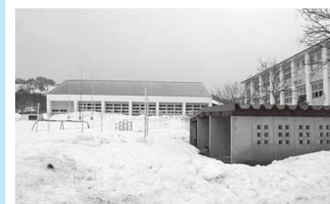
右側校舎は補強、正面体育館は改築
