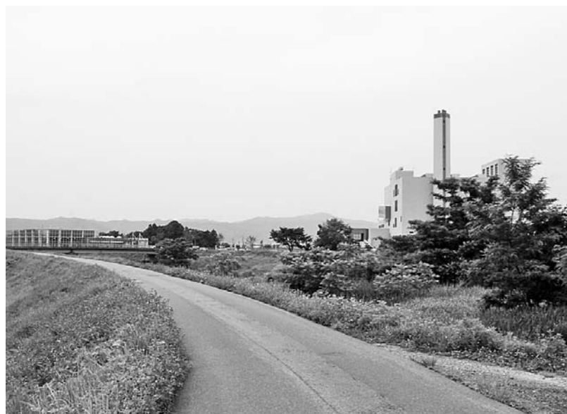
拡幅される搬入路
