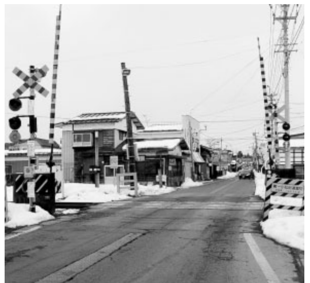
拡幅が望まれる第一小松街道踏切
