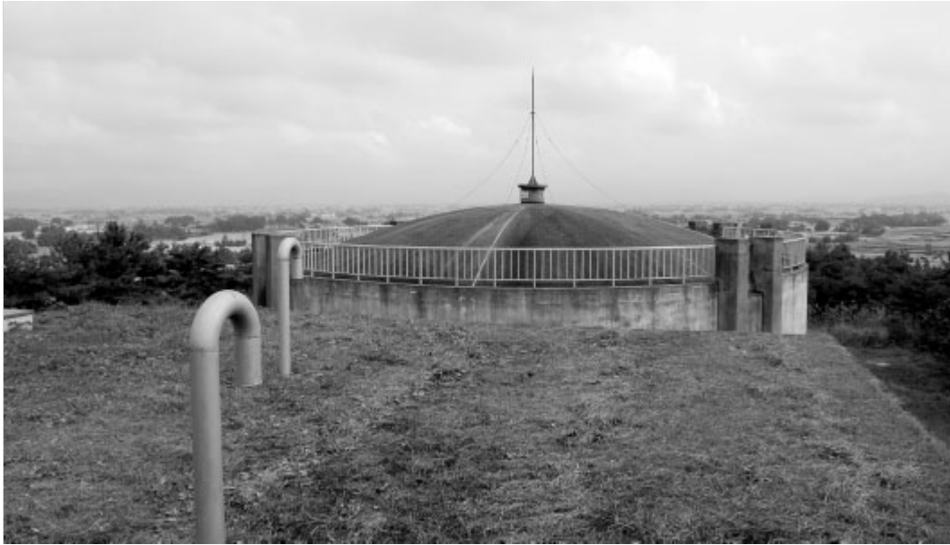
川西の水がめ八幡原配水池
