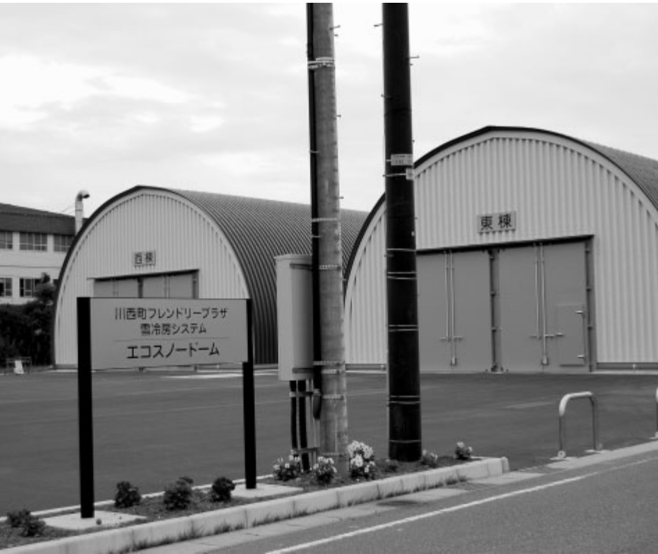
新エネルギービジョンで導入された雪冷房システム
