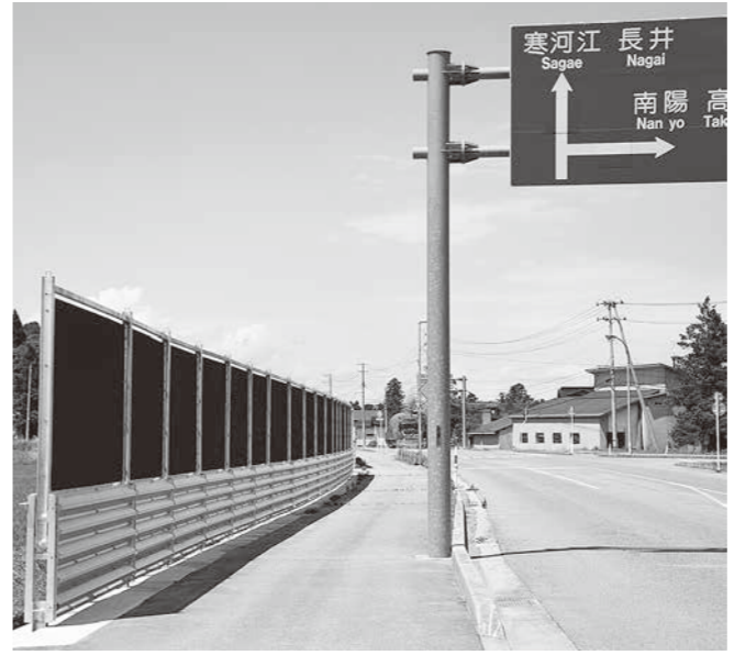
下小松地内=旧国道287号・西回り幹線Y字路付近(常設型防雪柵)
