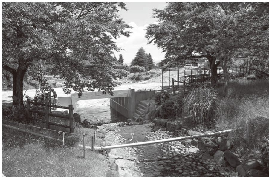
ボックスカルバート設置 = まどかに行く道路復旧工事
