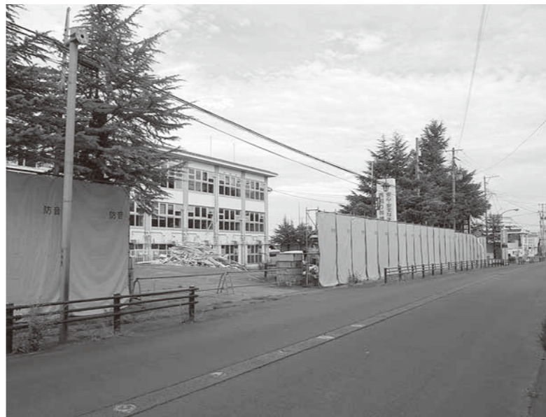
アスベスト対策も万全で、いよいよ解体が本格化 = 旧役場庁舎
