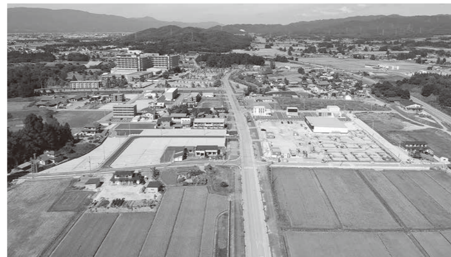
分譲も始まり着々と工事が進んでいるメディカルタウン = 大塚地内
