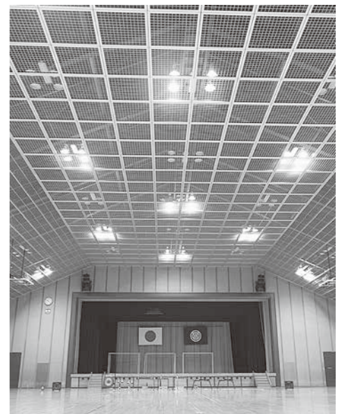
R4~R7で大規模改修計画の町民総合体育館吊り天井
