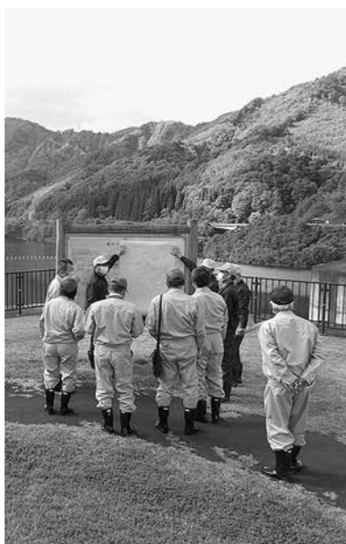
県企業局綱木川ダム
