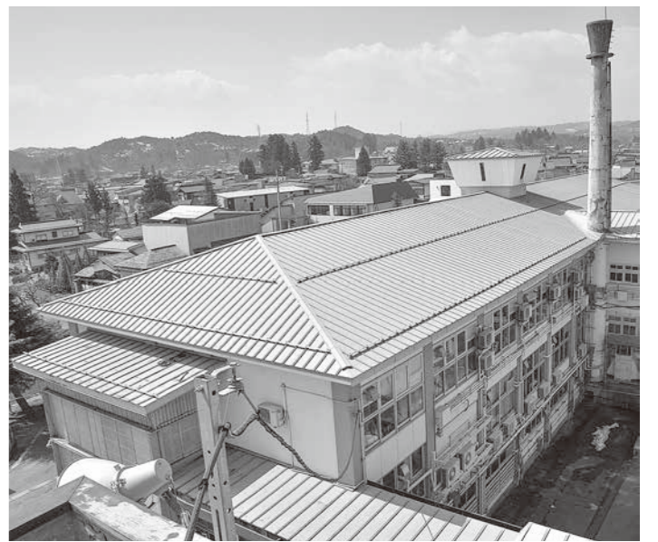
有効な跡地利用に期待 = 旧庁舎
