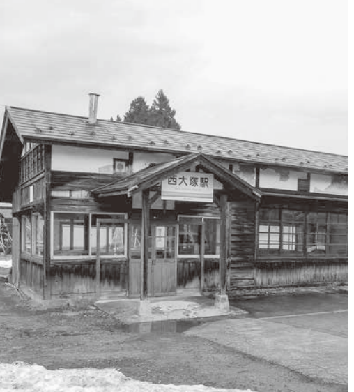
フラワー長井線西大塚駅 国登録有形文化財(建築物)でもある
