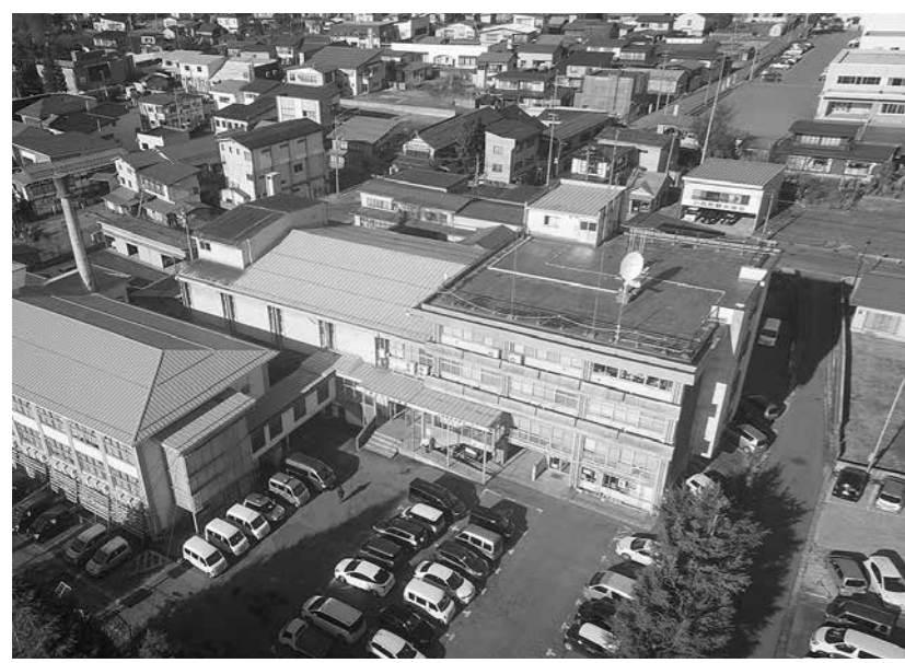
役場跡地利用と一体的に検討されている中央公民館
