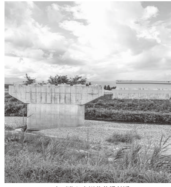
工事が進む犬川荒井橋付近
