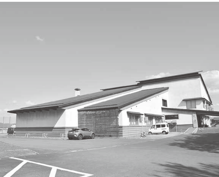
設備改修した農村環境改善センター
