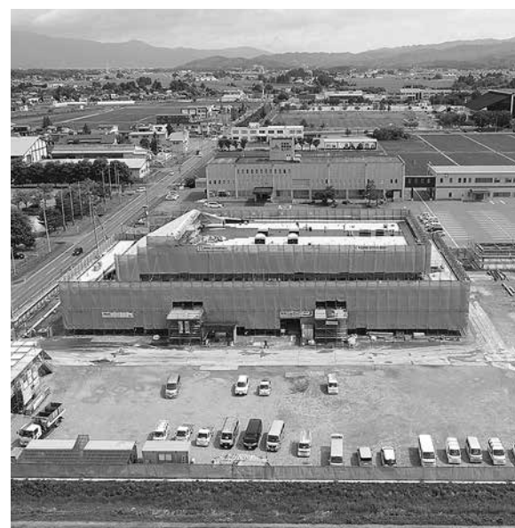
来春の開庁を目指し工事が進む新庁舎
