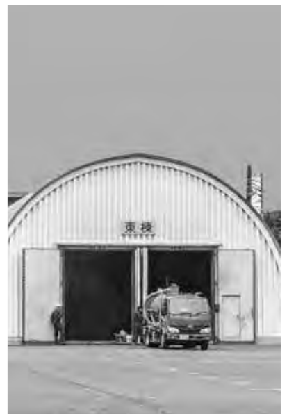
エコスノードーム整備点検中
