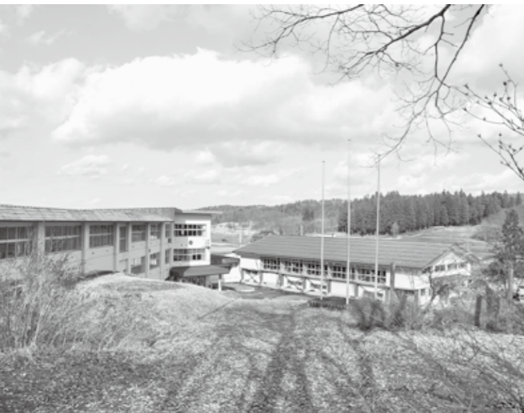
施設の有効利用はあるか - 旧東沢小学校
