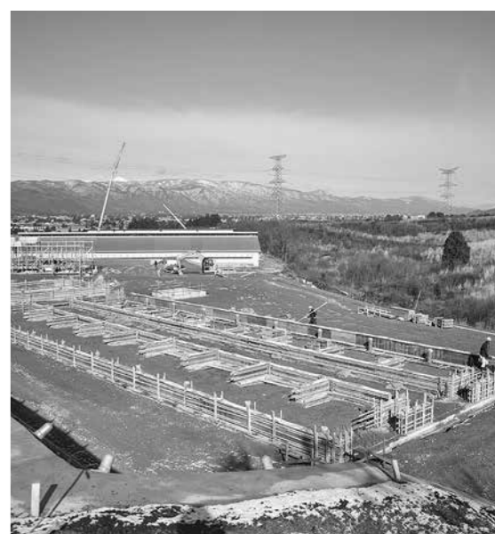
バイオマス発電施設=飯豊町で眺山に建設中
