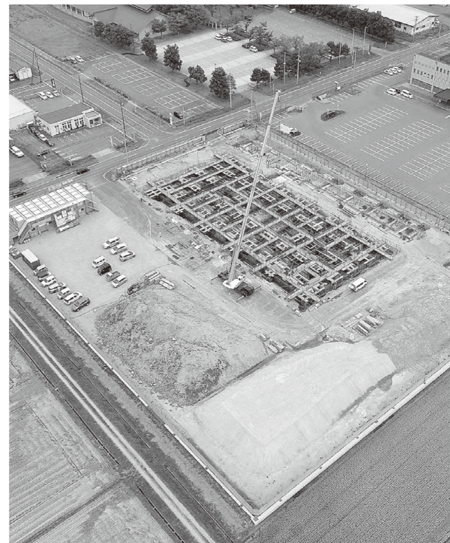
基礎工事が始まった新庁舎建設工事現場
