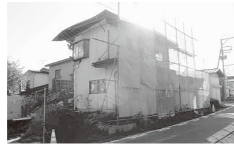
万全な空き家対策が望まれる = 代執行による解体
