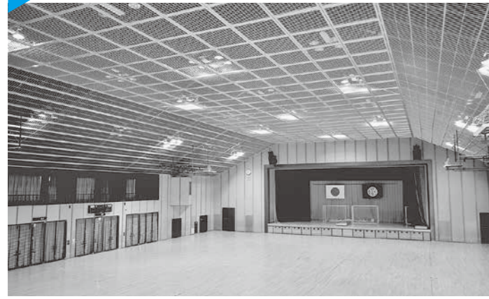
耐震化で長寿命化へ = 町民総合体育館
