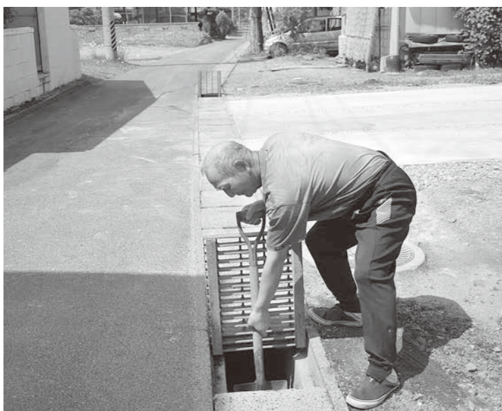
グレーティングを上げ泥上げ作業
