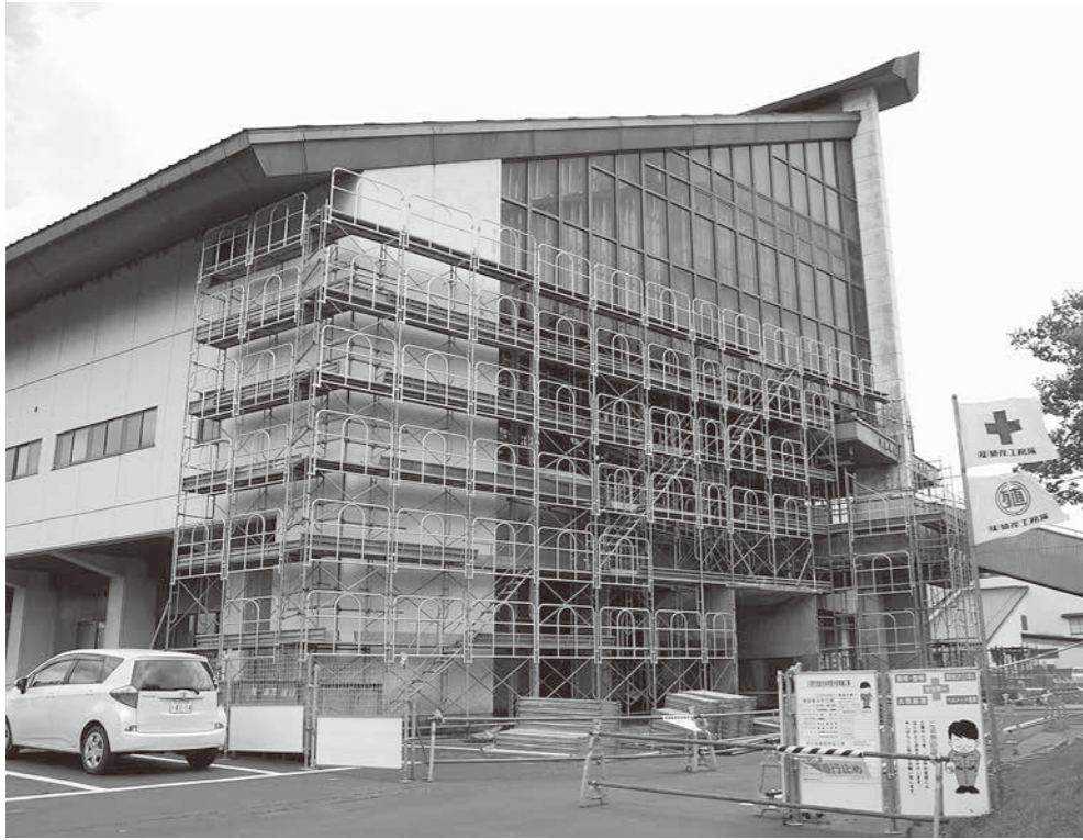
安全なスポーツ環境の整備を目指し町民体育館を修繕
