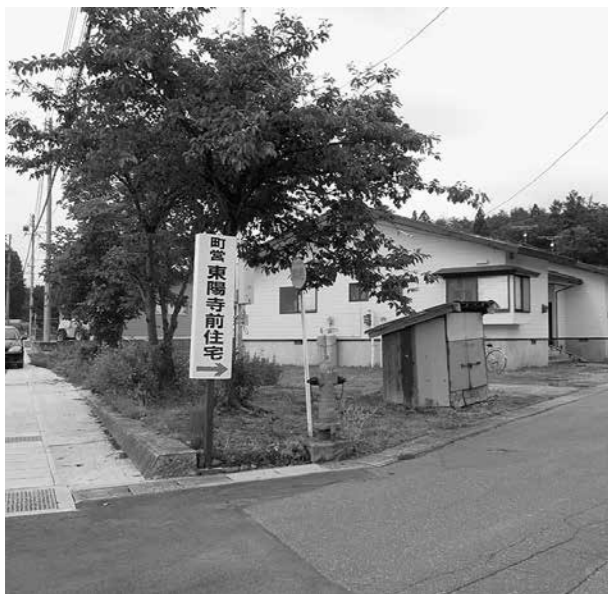
活断層がはしる町有施設
