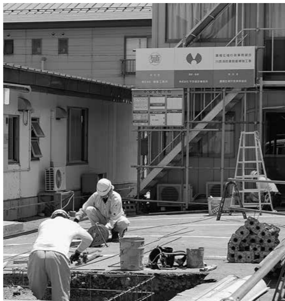
防災拠点の一つ、川西消防署の耐震工事始まる
