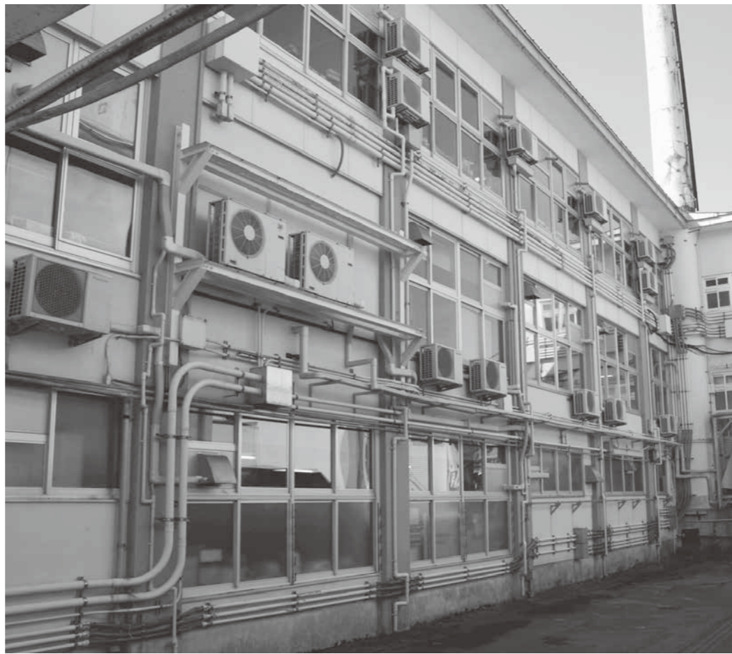
庁舎北側 耐震調査で
