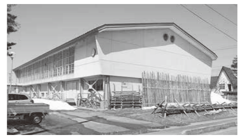
耐震化工事が行われる犬川小体育館
