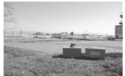
整地が完了した予定地
