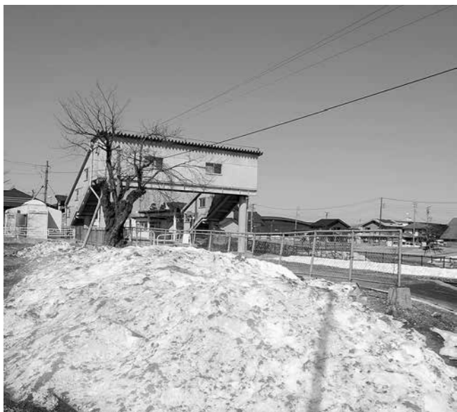
羽前小松駅、建設が待たれる夢のかけ橋 (東西自由通路)
