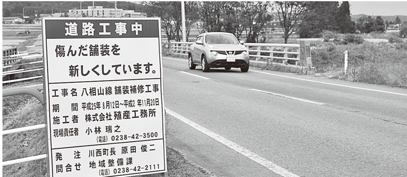
国の緊急経済対策で八相山線の路面舗装が行なわれる。(24年度からの繰越事業)
