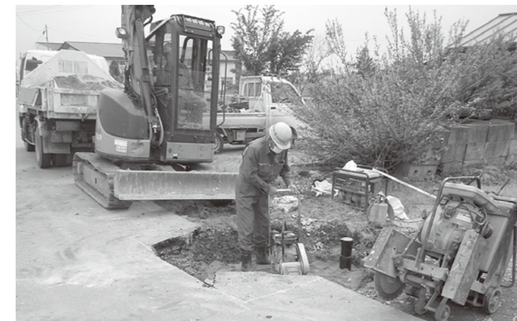
老朽水道管の入れ替え補修を計画的に
