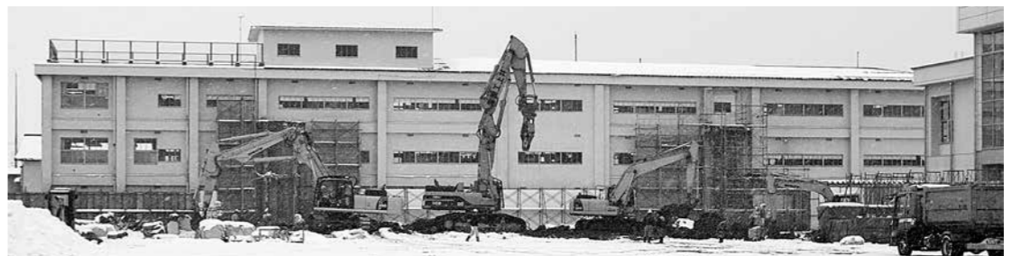
進む小松小学校の改築工事
