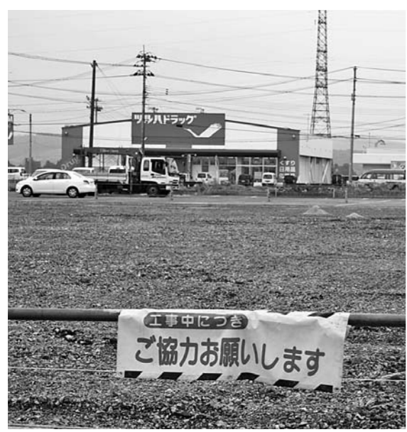
商業振興と活性化にどう資する(ヤマザワ川西店建設予定地)
