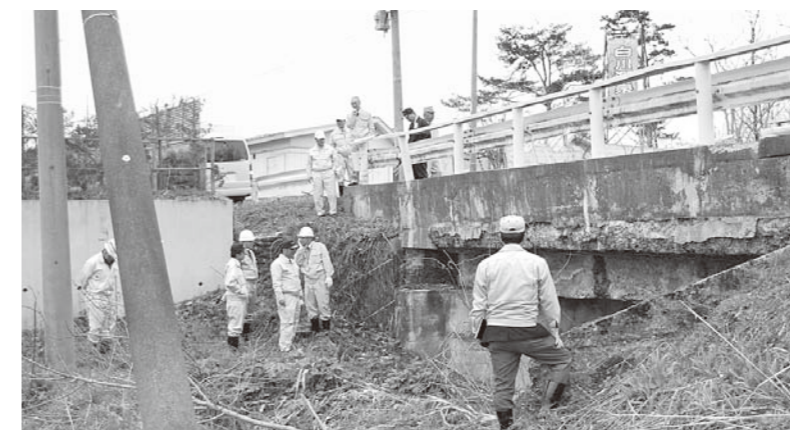
補修工事が実施される大塚堀橋
