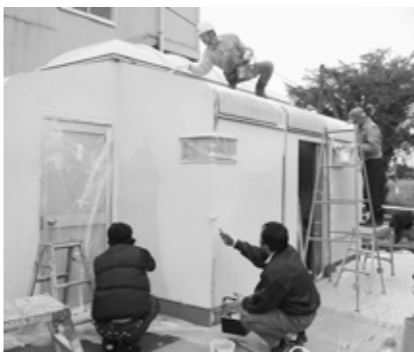
▲駅のトイレのペンキ塗り
