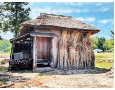
▲貴重な茅葺屋根の行屋(大字上奥田)
