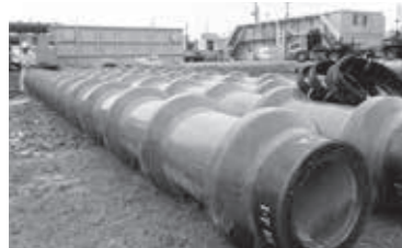
▲杭工事で使用した杭
