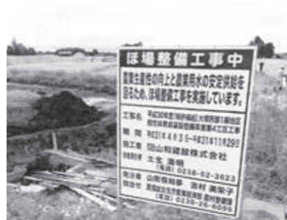
▲西大塚地区基盤整備事業がスタートした
