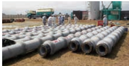
▲杭工事で使用する杭
