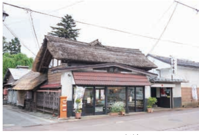
▲江戸時代後期建築(推定)の店舗兼主屋
