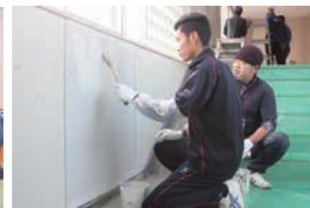
▲廊下の壁の塗装にチャレンジ
