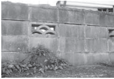
▲町内全域の道路に面したブロック塀を調査
