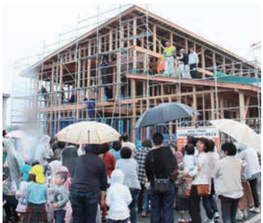
▲雨の中安全な工事を願って餅まき
