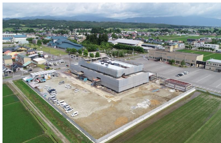
急ピッチで進む新庁舎建設
