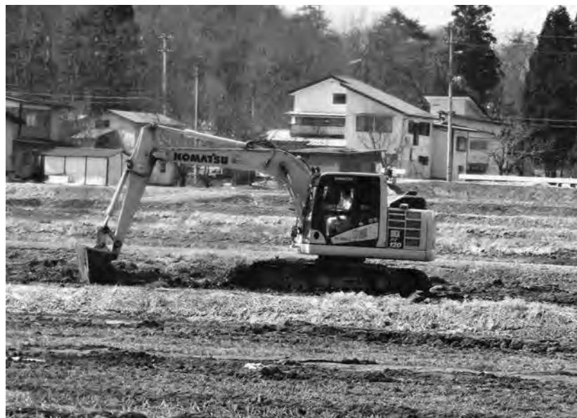
暗渠パイプ布設工事 = 西大塚地内
