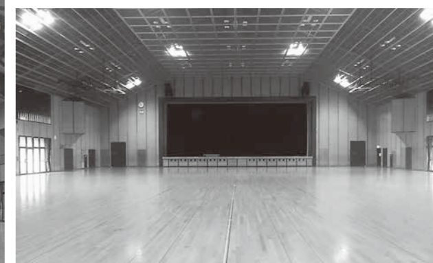
耐震工事前のアルミ格子天井
