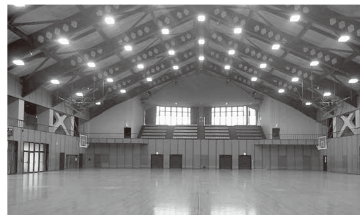
アルミ格子天井を取り外し危険回避
