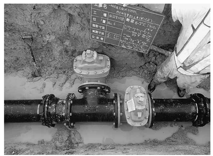
送水管の耐震化工事 = 八幡原地内県道244号
