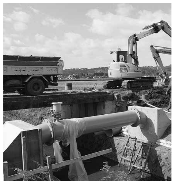
農業施設整備(上萩野) = 送水管工事
